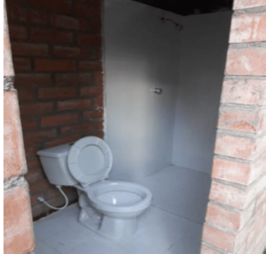
Inst. aparato sanitario y enchape Bateria sanitaria nueva
