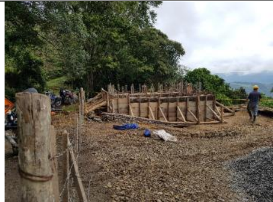
Foto Construcción Tanque de Almacenamiento Acueducto Interveredal Argelia
