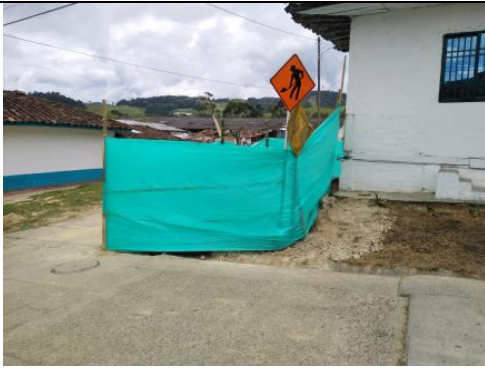
Cerramiento tramo 6 alcantarillado sanitario
