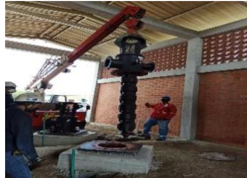
DESCRIPCION: Instalación de bombas de impulsión.
