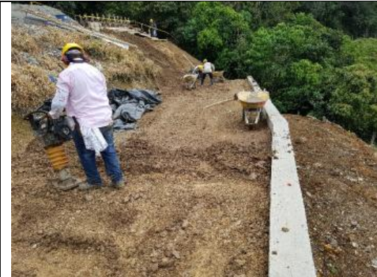
Foto Construcción Muro de Contención Acueducto Interveredal Argelia
