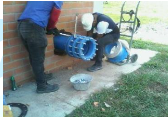
DESCRIPCION: Se inicia instalación de tubería de caseta de impulsión a tubería existente.
