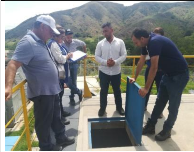
Contacto de cloro – Verificación de caudal
