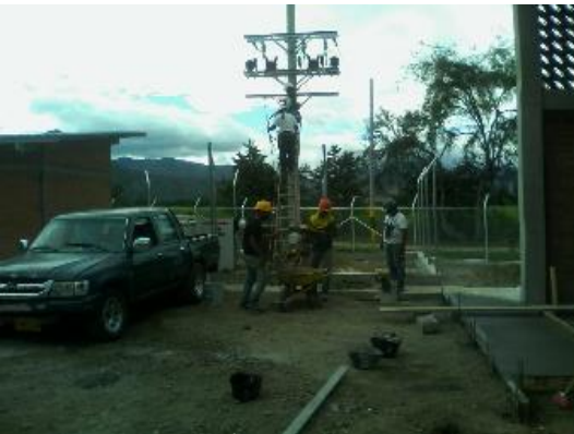
DESCRIPCION: Ejecución de actividades para acometida eléctrica de la subestación.
