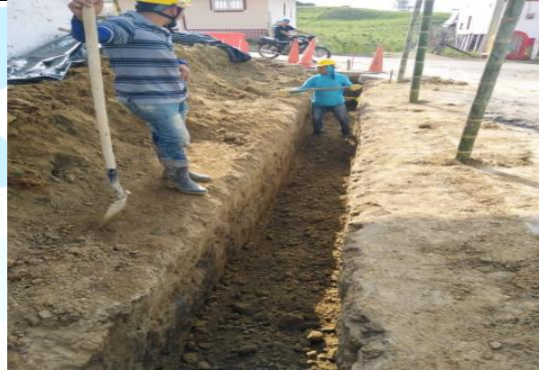
Relleno material comun compactado manual
