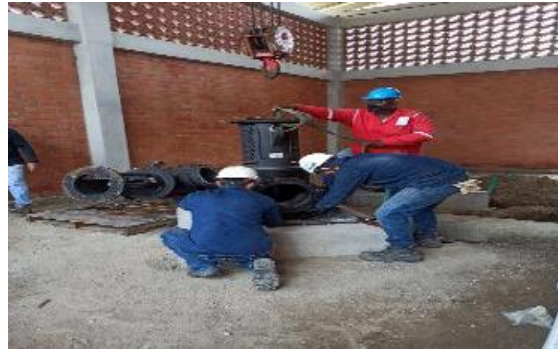
DESCRIPCION: Fundición bases e instalación de bombas de impulsión.
